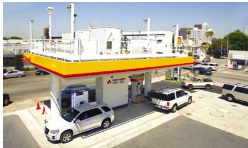
Estação de Abastecimento de Hidrogênio da Shell
